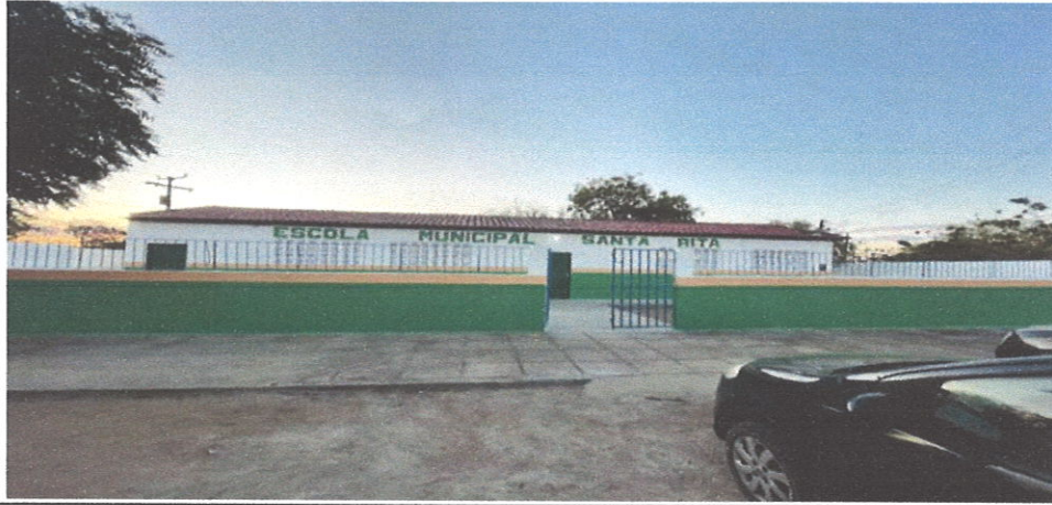
PINTURA DE ÁREA EXTERNA
